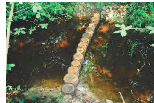
Prog spowalniający spływ wody
